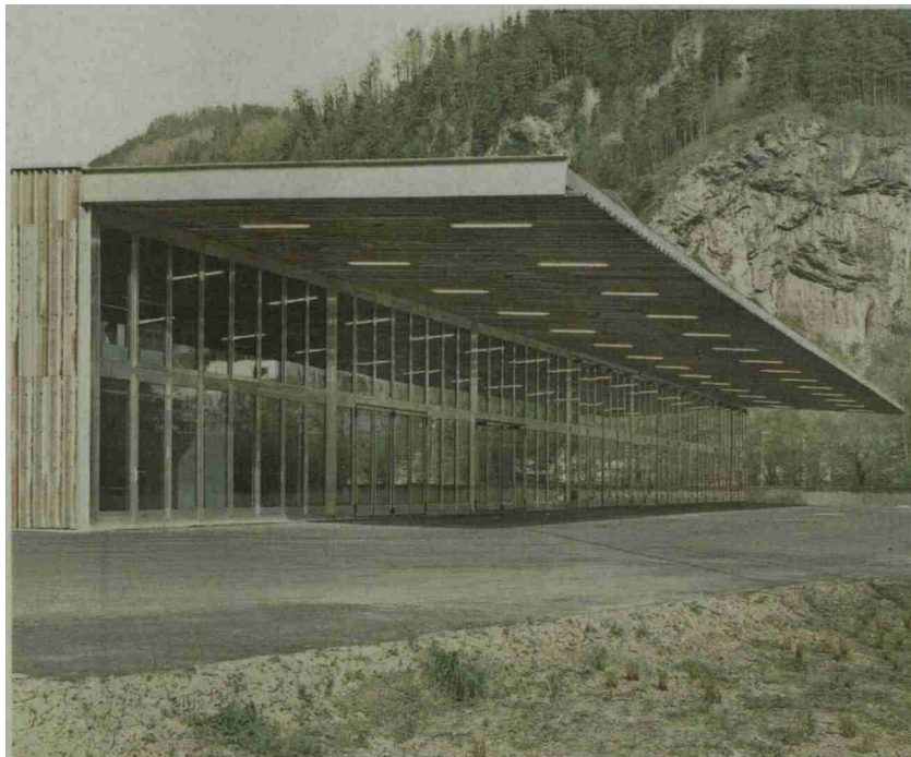
In der Kategorie Holzbauten wurde der Werkhof Betrieb Kantonsstrassen Uri in Schattdorf ausgezeichnet.
