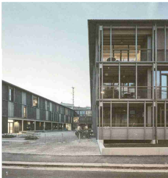
1 Der Ersatzneubau einer Wohnüberbauung in Basel verdichtet die Stadt und schafft angemessene öffentliche Räume. Foto: Kuster Frey
