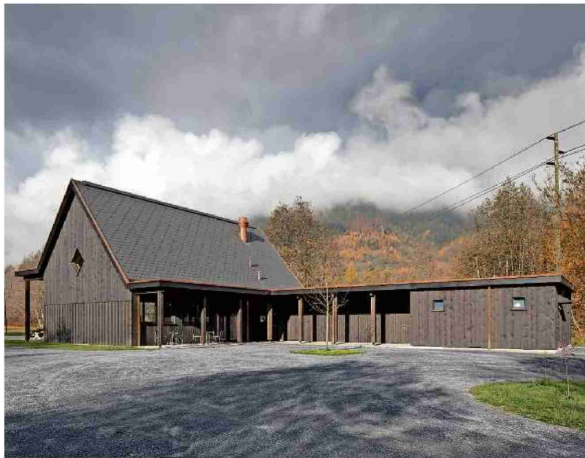
«Symbol von Schutz und Unterkunft im Erlenwald»: Das neue Gebäude-Ensemble auf dem Camping Oгна in Trun holte den ersten Sonderpreis von Graubünden Holz. Bild Ralph Feiner
