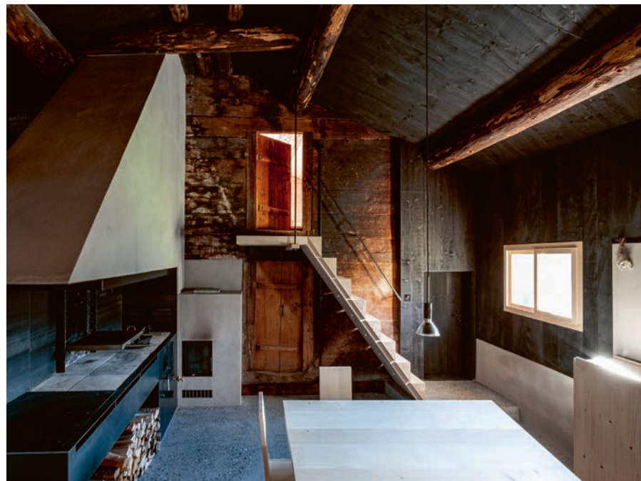
Die Wand- und Deckenverkleidung aus sägerohem, schwarz gebeiztem Holztafer bildet den Hintergrund für die rohen Rundbalken. Die Jury des Prix Lignum honorierte das Projekt mit dem Sonderpreis Schreiner.
