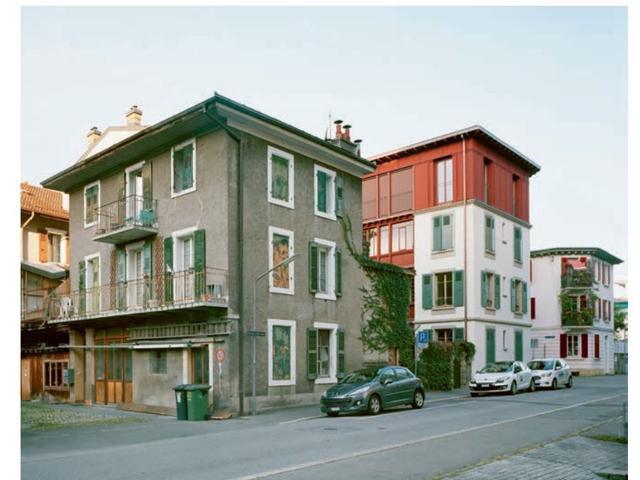
Aufgestockt und umgebaut: Das Mehrfamilienhaus in Vevey zeigt, dass die Nachverdichtung ein Gewinn sein kann. Prämiert wurde das Projekt mit dem Prix Lignum in Bronze.
