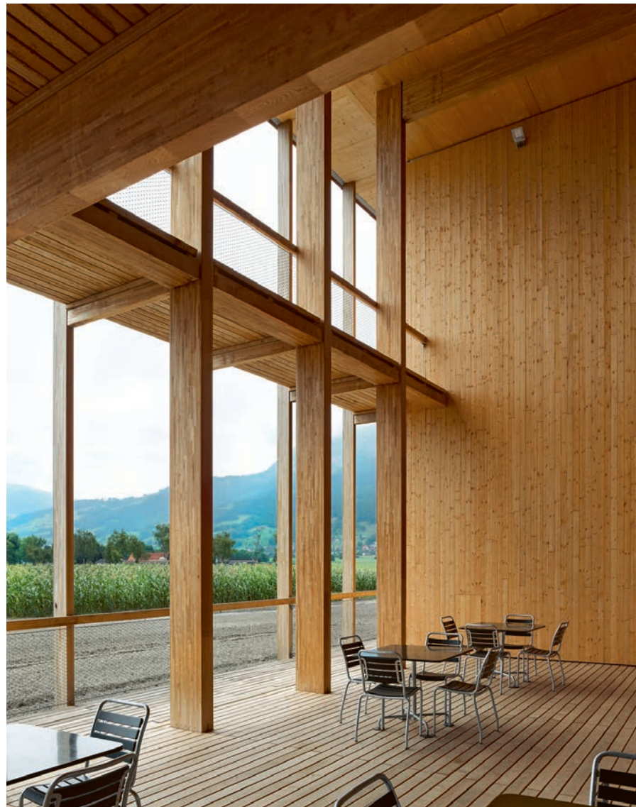
Im Innern des Landwirtschaftlichen Zentrums Salez wird der Stützenraster von 2,14 Metern mehrfach aufgelöst: unter anderem durch eine teils über zwei Geschosse reichende Terrasse, die ins Gebäude eingeschnitten ist.
