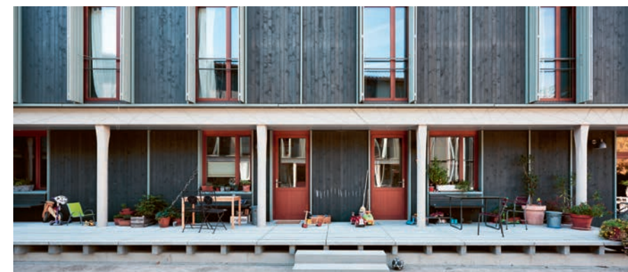
Die Gabelstützen tragen gemeinsam mit Holzelementwänden massive Brettschichtholzträger, die das Gebäude über die gesamte Länge zusammenbinden.
