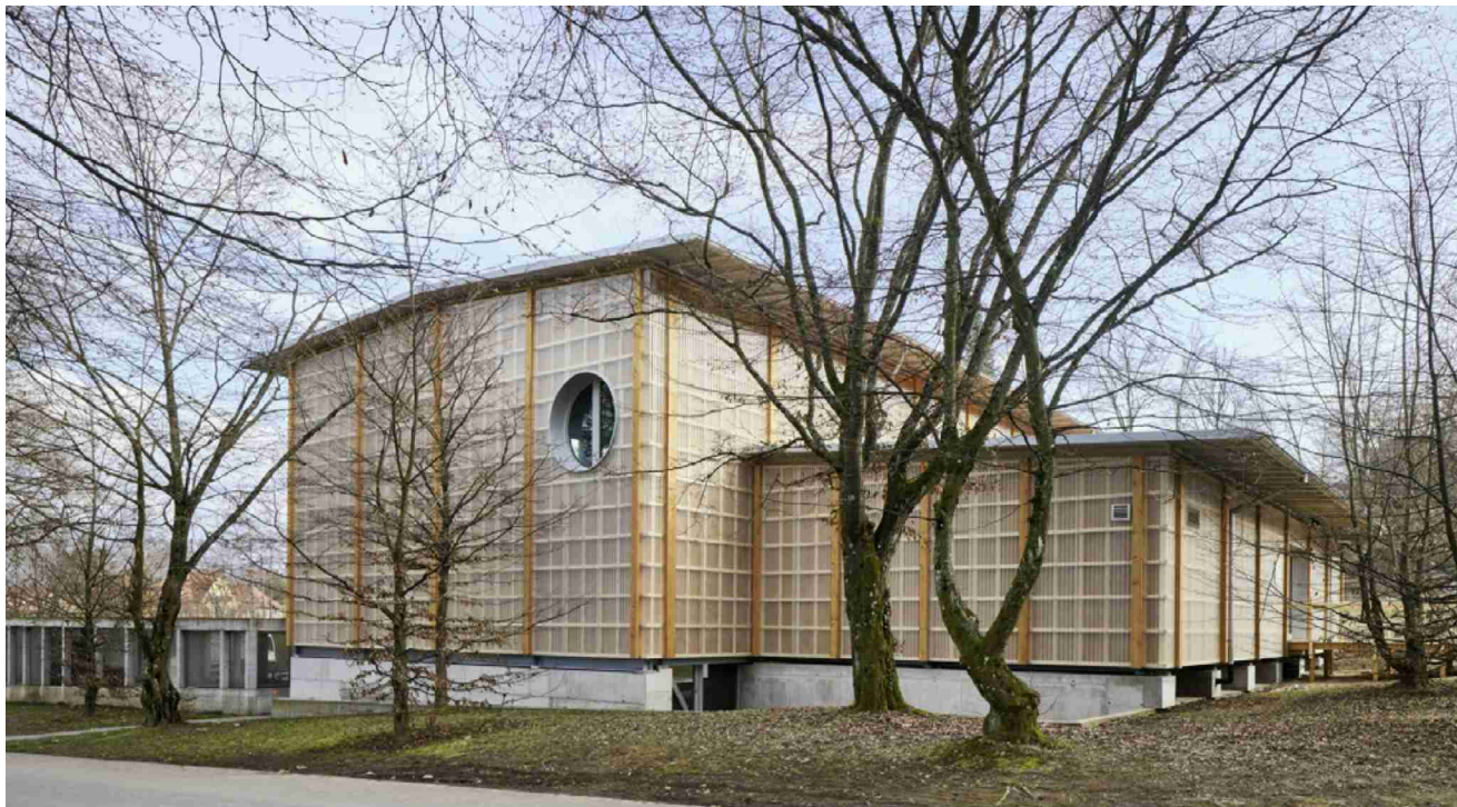
Prix Lignum 2024 in Gold für provisorische Sportbauten in Stadt und Kanton Zürich, die wiederverwendbar sind. Die Turnhalle der Schule Dölttschi in Zürich beeindruckt mit Nachhaltigkeit und durchdachtem Design.
