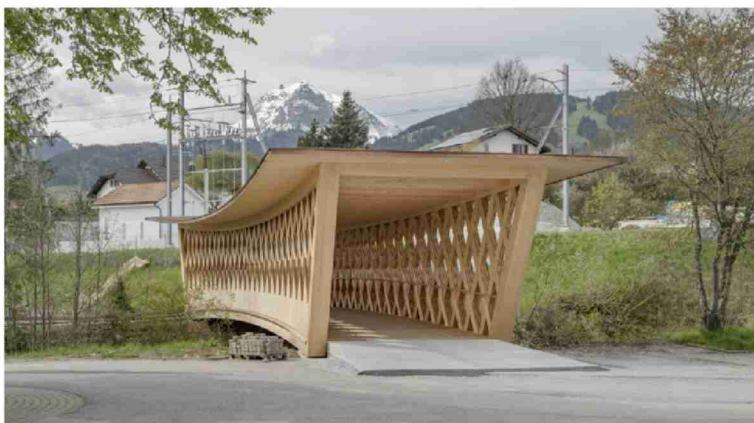
Prix Lignum 2024 in Bronze für die Passerelle des Buissons über den Fluss Trême. Die Konstruktion ermöglichte es, die Materialmenge zu reduzieren.
