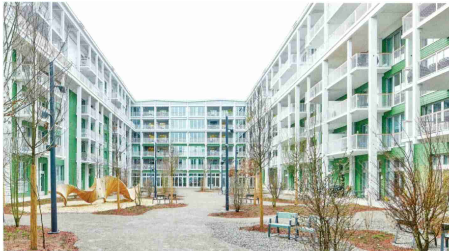
Wohnungen in Winterthur: Holz wurde u.a. neben Beton und Stahl vielseitig eingesetzt.
