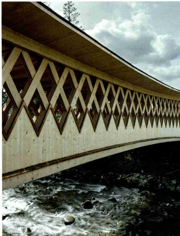
Passerelle von Buisson: Neuinterpretation eines klassischen Fachwerks.
