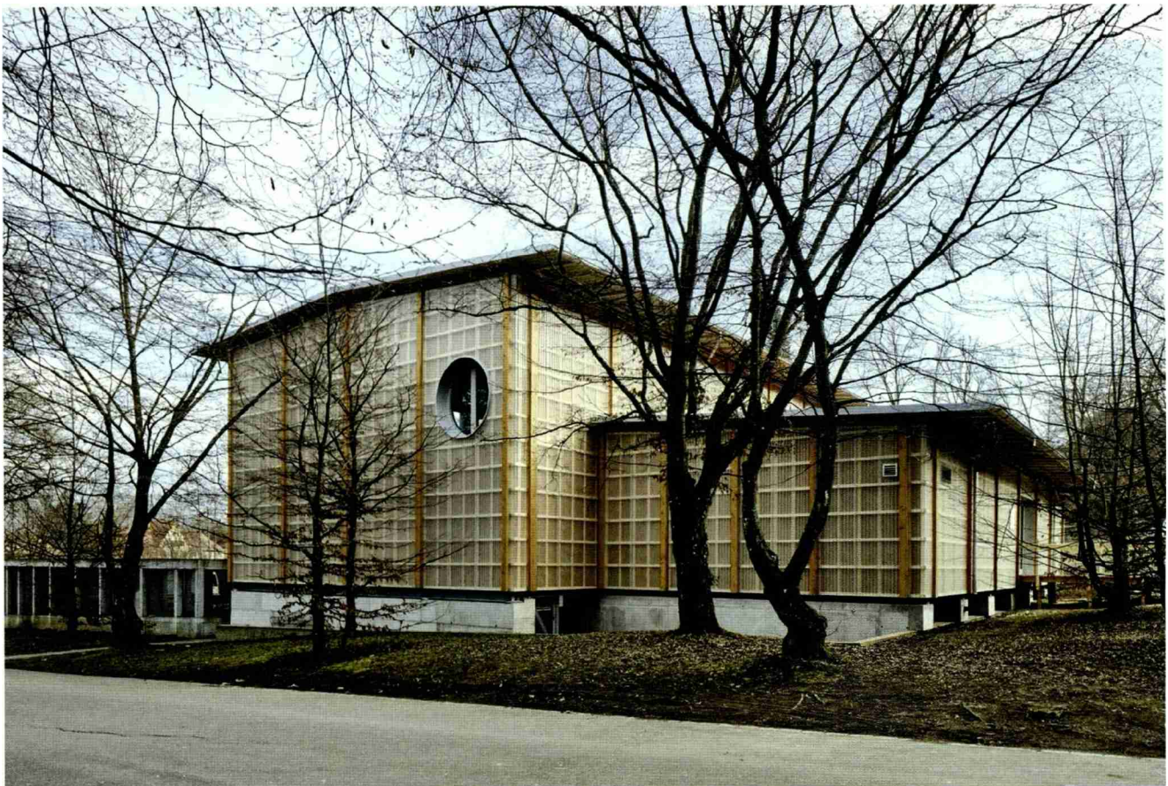
Provisorische Schulbauten der Kantonsschule Uetikon am See im Kanton Zürich.
