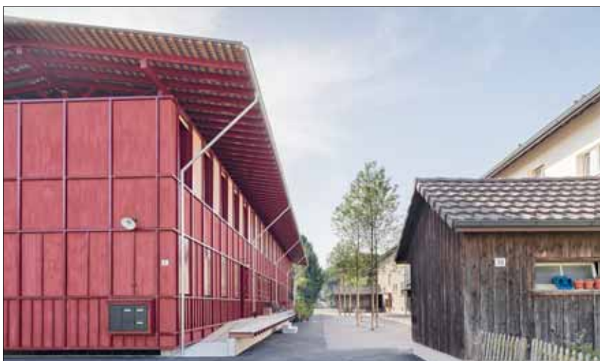
Abbildung 3 Pappelhöfe, Wohnkolonie im Hard (Langenthal): Drei neue, aus Holz gebaute Reihenhausriegel mit insgesamt zwölf Häusern ergänzen und verdrängen eine aus den 1940er-Jahren stammende Arbeitersiedlung. Die Fassaden sind mit einer Leinöl-Emulsionsfarbe schwedenrot gestrichen, die gliedernden Leisten erhielten einen dunkelroten Anstrich aus Ölfarbe. Foto: Alexander Gempeler
