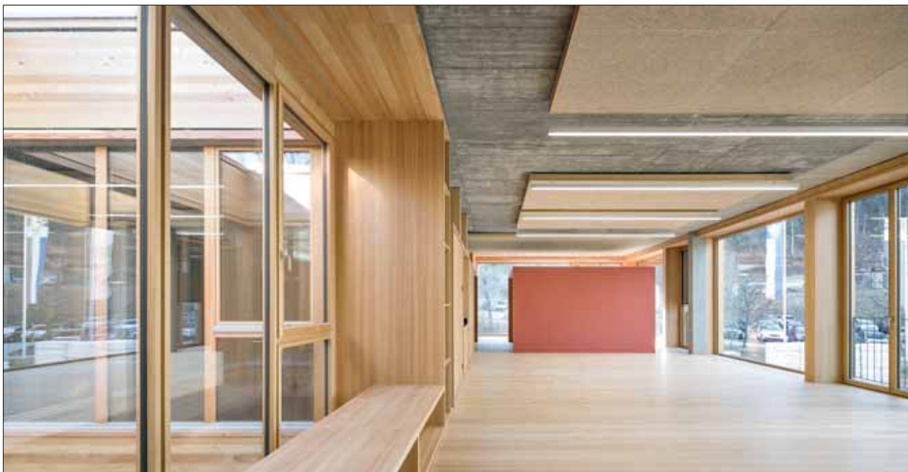
Abbildung 5 Mit einem Ausbau in Holz veränderte sich der Charakter des vorher durch Beton geprägten Pavillons aus den 1970er-Jahren. Geschaffen wurden so Räume mit einer ruhigen Grundstimmung. Die eigens entwickelten Wände aus Lärchenholz sind gleichzeitig Wandschränke. Foto: Ingo Rasp
