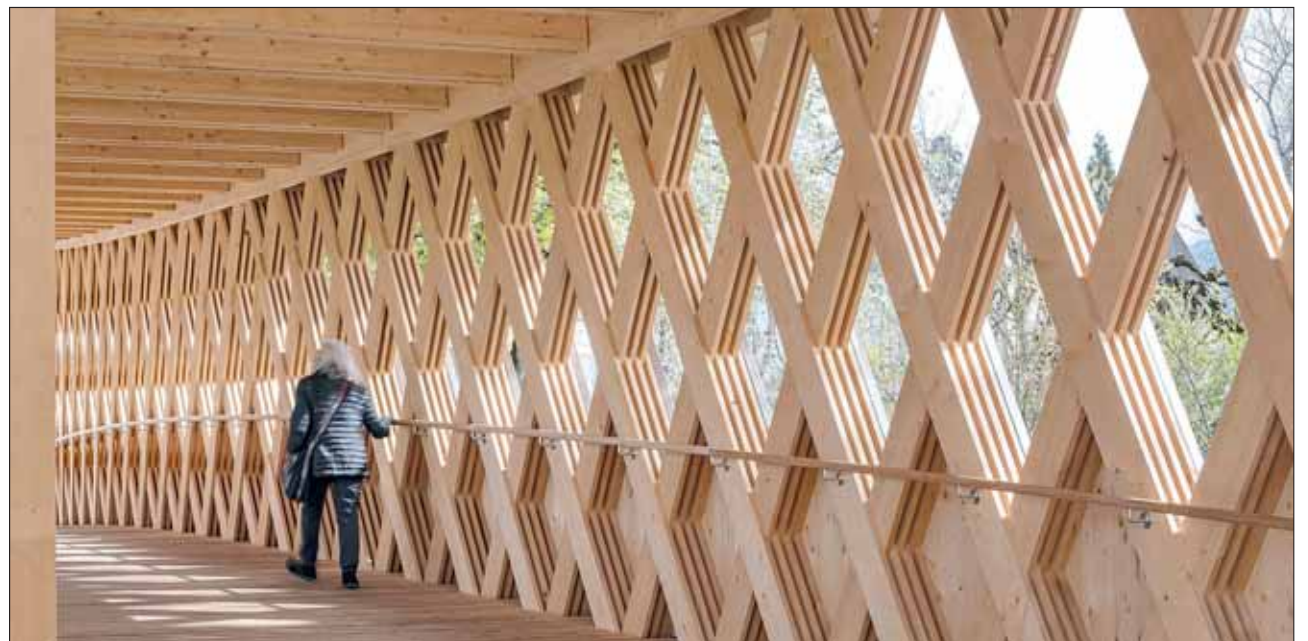
Abbildung 4 Passerelle des Buissons, Bulle: Der Brückensteg verbindet das Stadtzentrum von Bulle mit dem Quartier La Tour-de-Trême und dem künftigen Neubaugebiet Buissons. Die Konstruktion erinnert an das US-amerikanische Lattenbausystem für Brücken des 19. Jahrhunderts. Das Bauwerk besticht gestalterisch wie technisch. Foto: Vincent Jendly
