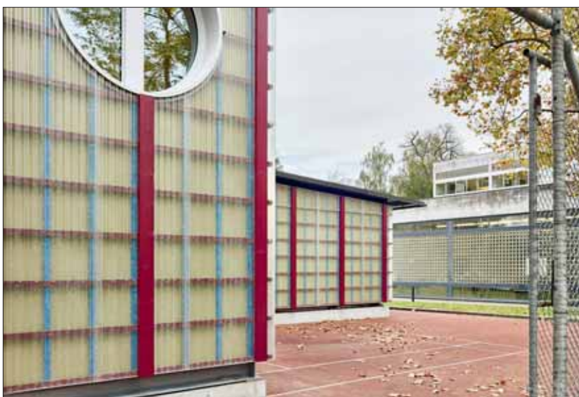
Abbildung 2 Wiederverwendbare Sportbauten in Zürich: Die Holzkonstruktion ist mit transparenten gewellten, glasfaserverstärkten Kunstharzplatten verkleidet. Je nach Standort werden die Unterkonstruktion und die Winddichtung farblich gestaltet. Foto: Ralph Feiner
