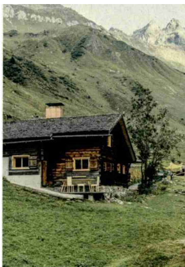
Porträt des umgebauten historischen Strickbaus auf einer Alp oberhalb von St. Antönien.
