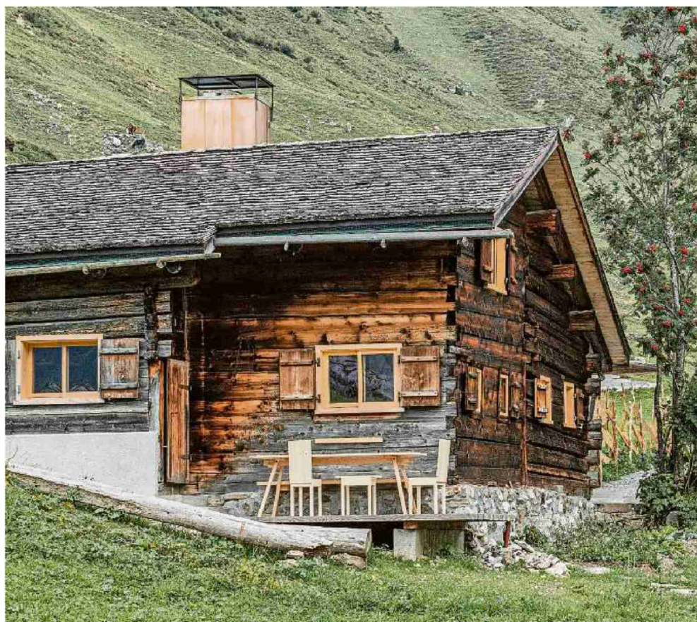
Für den Ort geschaffen: Die umgebaute Alphütte. Auf der Terrasse steht ein Teil der eigens für die Hütte gezimmerten Möbel.
