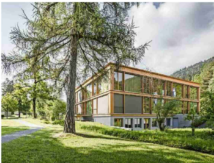
Aussenansicht des ausgezeichneten Umbaus von Haus 8 in der Klinik Beverin in Cazis.
