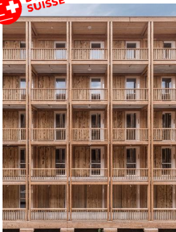
Centre d'hébergement collectif de Rigot à Genève
